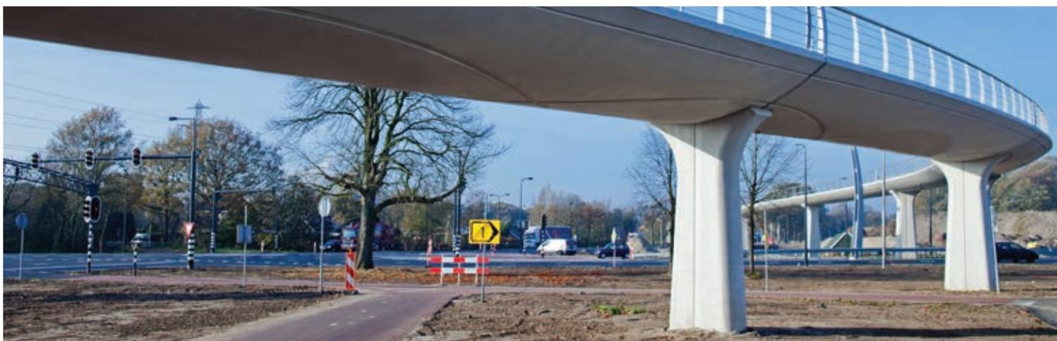
**Haitsma Beton liefert außerdem verschiedene Spezialträger, darunter der massive gebogene Brückenträger und der I-Profil-Träger. Darüber hinaus liefern wir auch T-Profil-Träger.**
